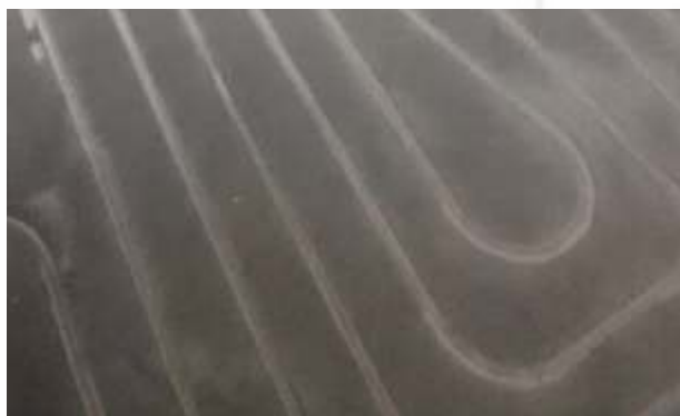
Eingeschlämmte Heizrohrkanäle
