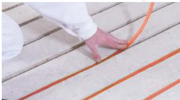
Rohrverlegung der Heizkreise
