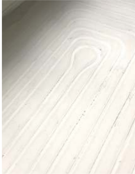
Eingeschlammte Heizrohrkanäle
