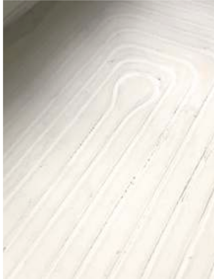
Eingeschlammte Heizrohrkanäle
