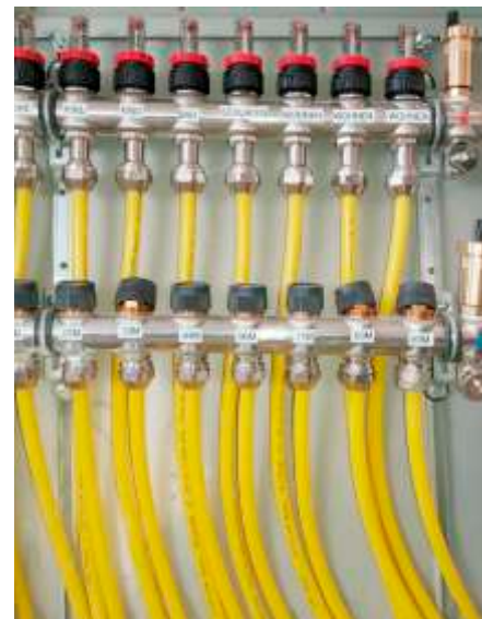
Angeschlossener Heizkreisverteiler
