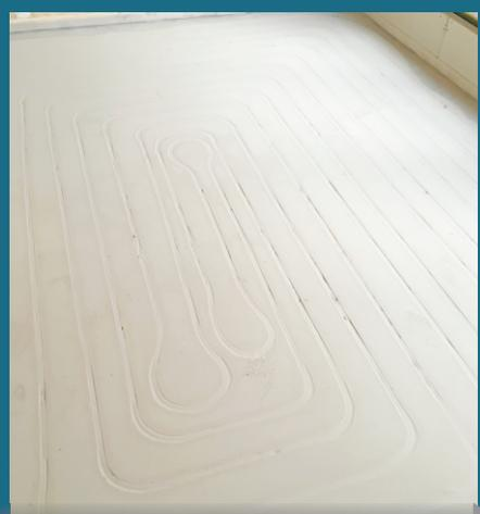
Nach dem Einschlämmen/Trocknen des Flexspachtel setzt ein Schwindungsprozess ein. Es entsteht keine glatte, homogene Fläche.
