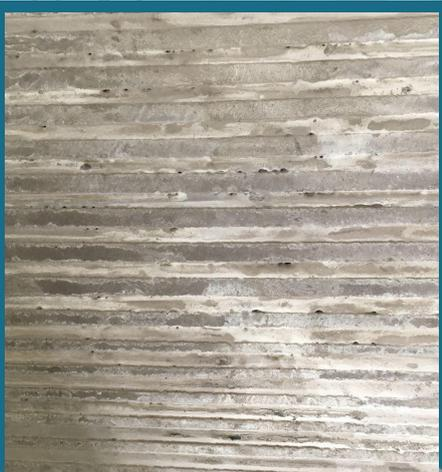
Das Einschlämmen der Fräskanäle ersetzt keine belegreife Oberfläche. Bei verklebten Oberböden wie Parkett oder Vinyl muss der Boden durch den Bodenleger bauseits ausgeglichen werden
