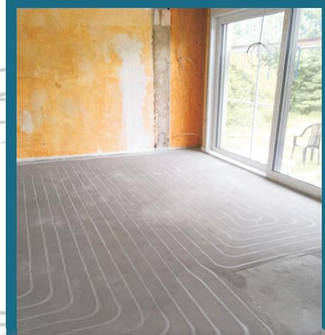
Das Einschlämmen dient nur der Wärmeflächenverteilung - nicht zum Schutz des Rohres oder zur Nivellierung der Oberfläche. Es können Fehlstellen zwischen Rohr und Fräskanal entstehen.
